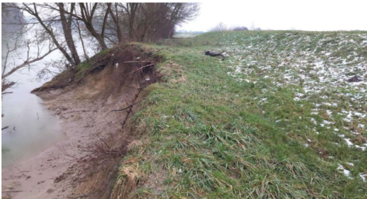
Slika 2-1: Odron na desnoj obali rijeke Save kod naselja Strelečko u rkm 621-rkm
