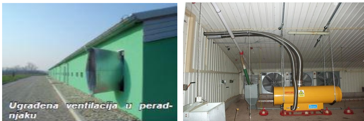
Slika 20.: Sustav za provjetravanje u peradarniku
