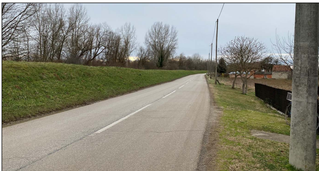
Slika 34. Nasip i državna cesta DC47 na lokaciji 13 (pogled prema zapadu)
