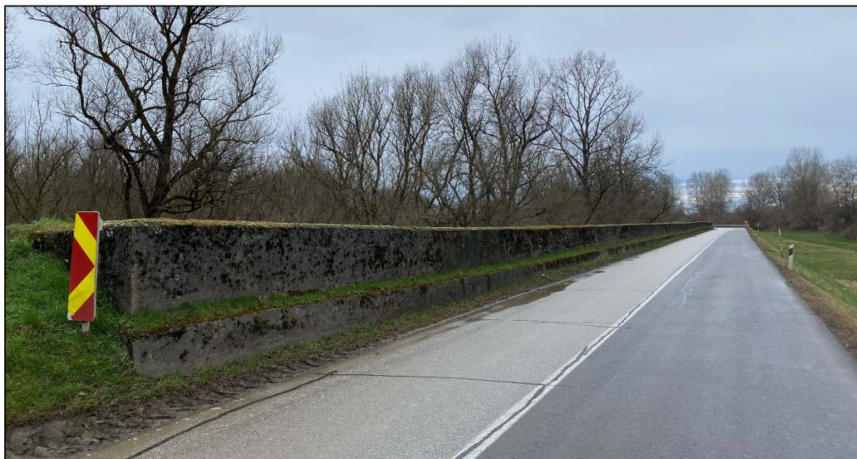
Slika 18. Zid uz državnu cestu DC47 (pogled prema zapadu)
