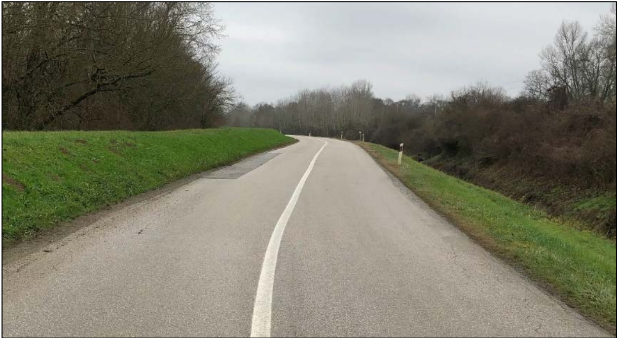
Slika 5. Nepregledan zavoj na predmetnoj dionici
