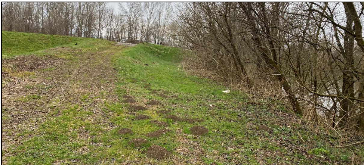
Slika 23. Lokacija predviđena za otvor u nasipu na km 0+960 (pogled prema sjeveroistoku, odnosno prema državnoj cesti DC47
