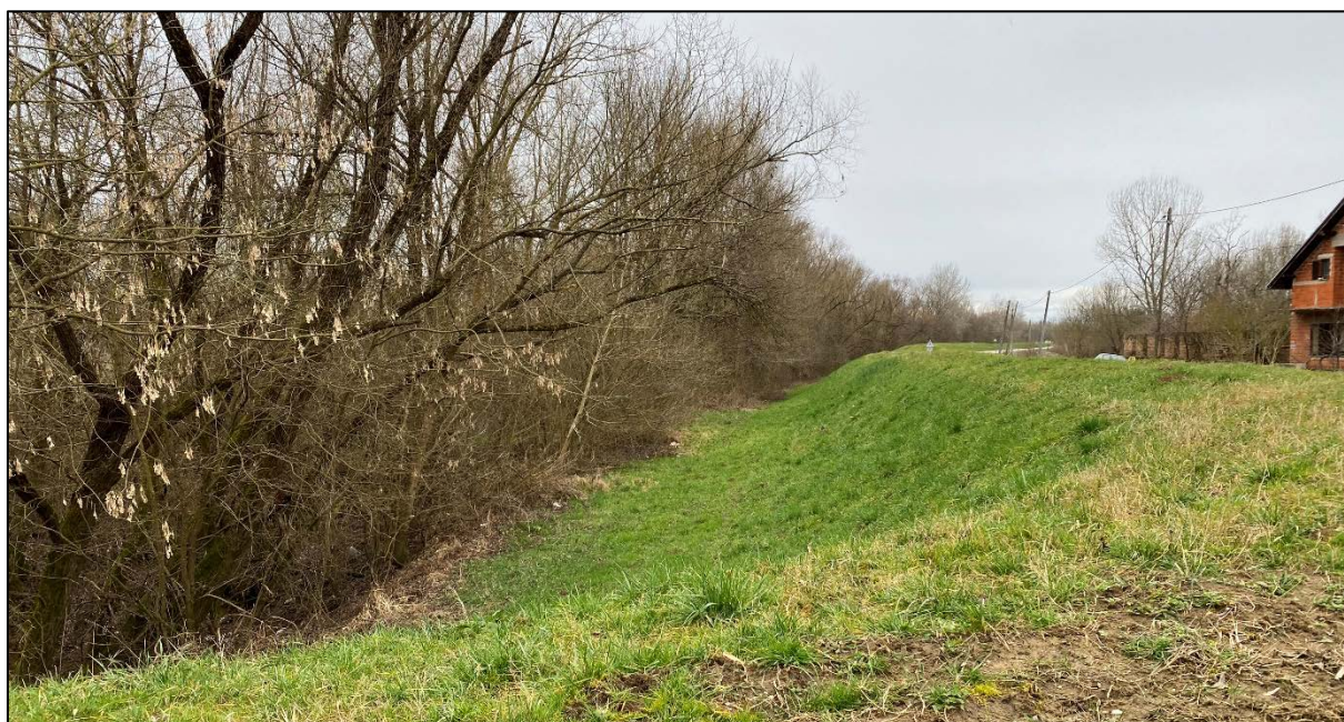
Slika 32. Nasip na lokaciji 12 (pogled prema zapadu)
