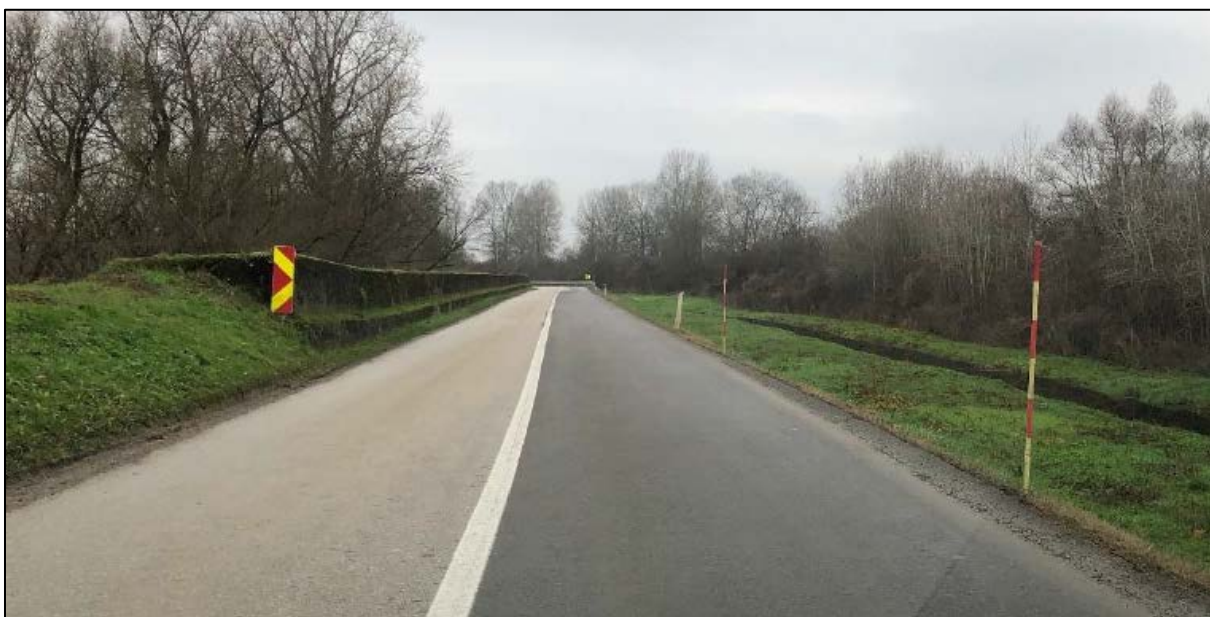
Slika 7. Početak betonskog zida
