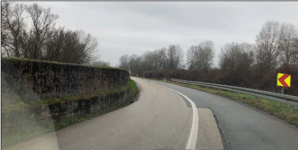
Slika 8. Neposredna blizina betonskog zida kolniku državne ceste
