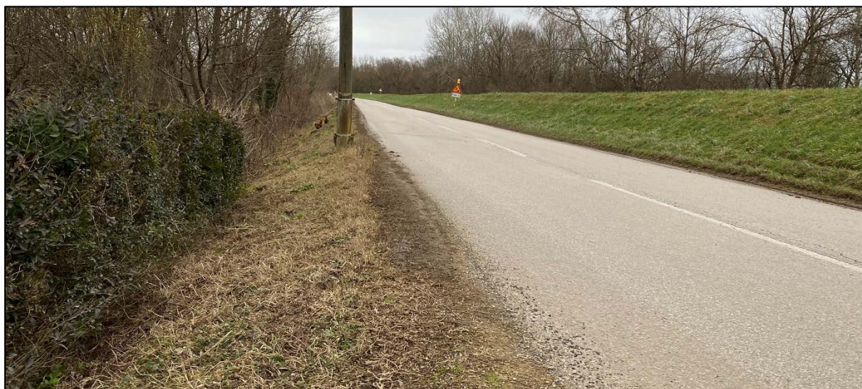
Slika 33. Nasip i državna cesta DC47 na lokaciji 13 (pogled prema istoku)
