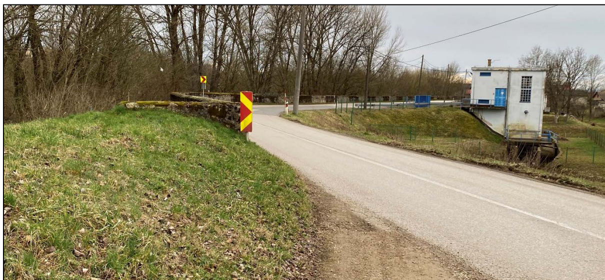
Slika 29. Završetak dionice I (pogled prema jugozapadu)
