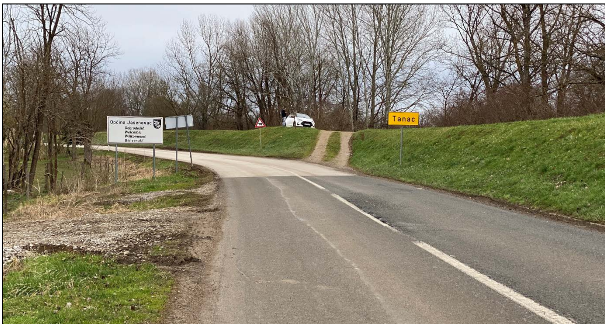
Slika 36. Završetak dionice II na ulazu u naselje Tanac (pogled prema istoku)
