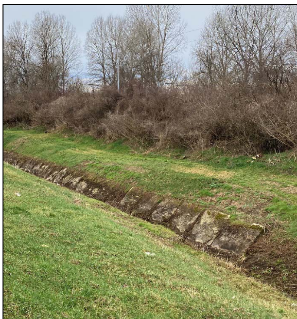
Slika 20. Odvodni kanal s vidljivim popločenjem
