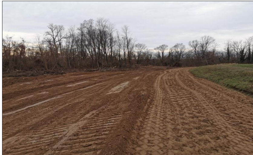
Slika 2.1-3. Izvođenje radova privremene sanacije nasipa –izvedba zemljane berme na vodnoj strani (Hrvatske vode, siječanj, 2021.)
