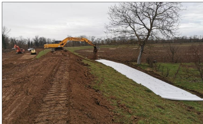
Slika 2.1-4. Izvođenje radova privremene sanacije nasipa –izvedba zemljane berme na branjenoj strani (Hrvatske vode, siječanj, 2021.)
