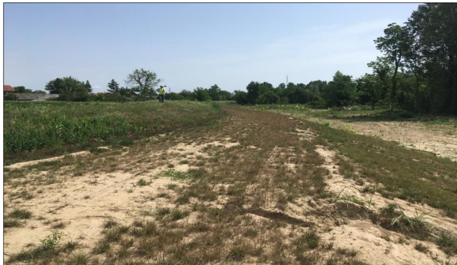
Slika 2.2-2. Postojeće stanje nasipa nakon privremene sanacije berme na vodnoj strani (INSTITUT IGH, d.d., srpanj, 2021.)
