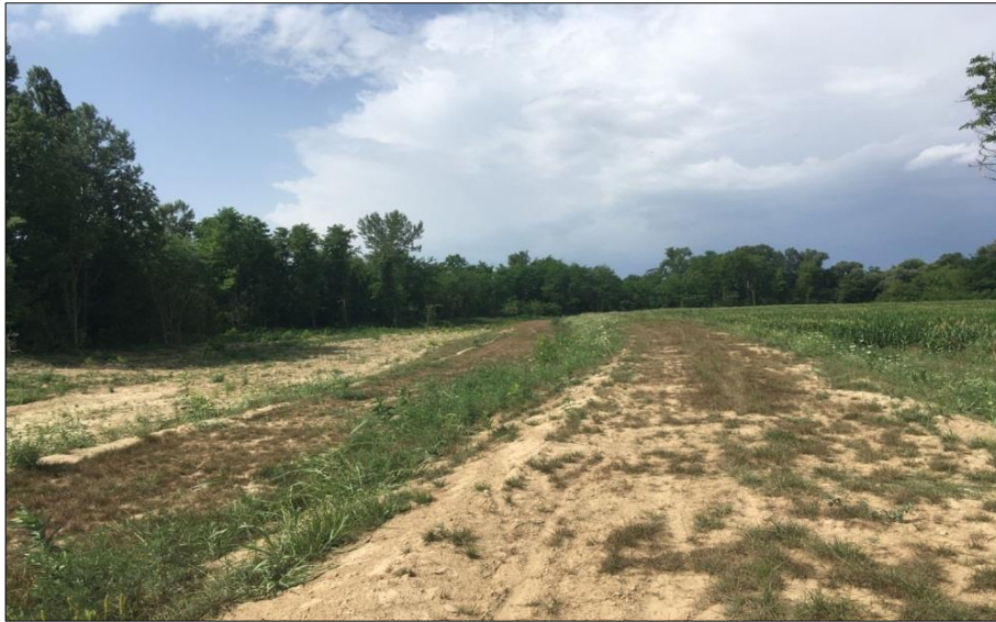
Slika 2.2-3. Postojeće stanje nasipa - prikaz snižene krune nasipa (INSTITUT IGH, d.d., srpanj, 2021.)
