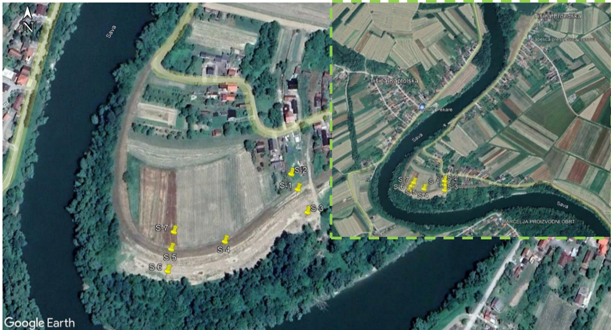
Slika 3.3.3-1. Pregled istraživanog terena s prikazom istražnih bušotina na trasi nasipa (izvor: Geotehnički izvještaj, INSTITUT IGH, d.d., rujan 2021.)
