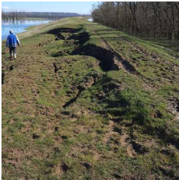
Grafički prikaz 3-4: Izgled nasipa u n.km 5+400 nakon potresa
