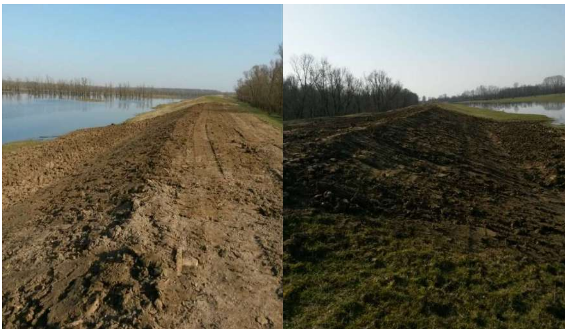
Grafički prikaz 3-6: Izgled nasipa u n.km 5+400 nakon sanacije
