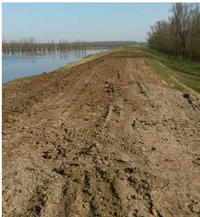
Grafički prikaz 3-9: Izgled nasipa u n.km 6+200 nakon sanacije
