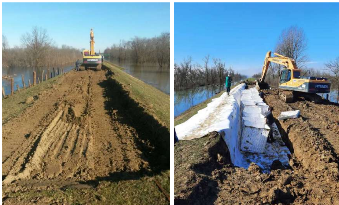
Grafički prikaz 3-8: Sanacija nasipa u n.km 6+200 sklopu hitne intervencije
