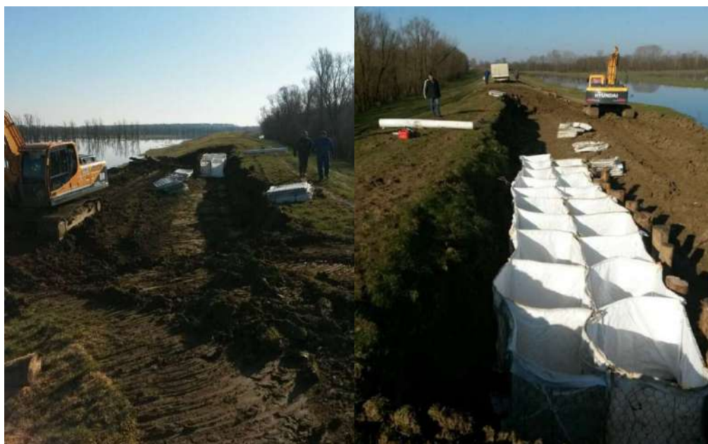
Grafički prikaz 3-5: Sanacija nasipa u n.km 5+400 sklopu hitne intervencije
