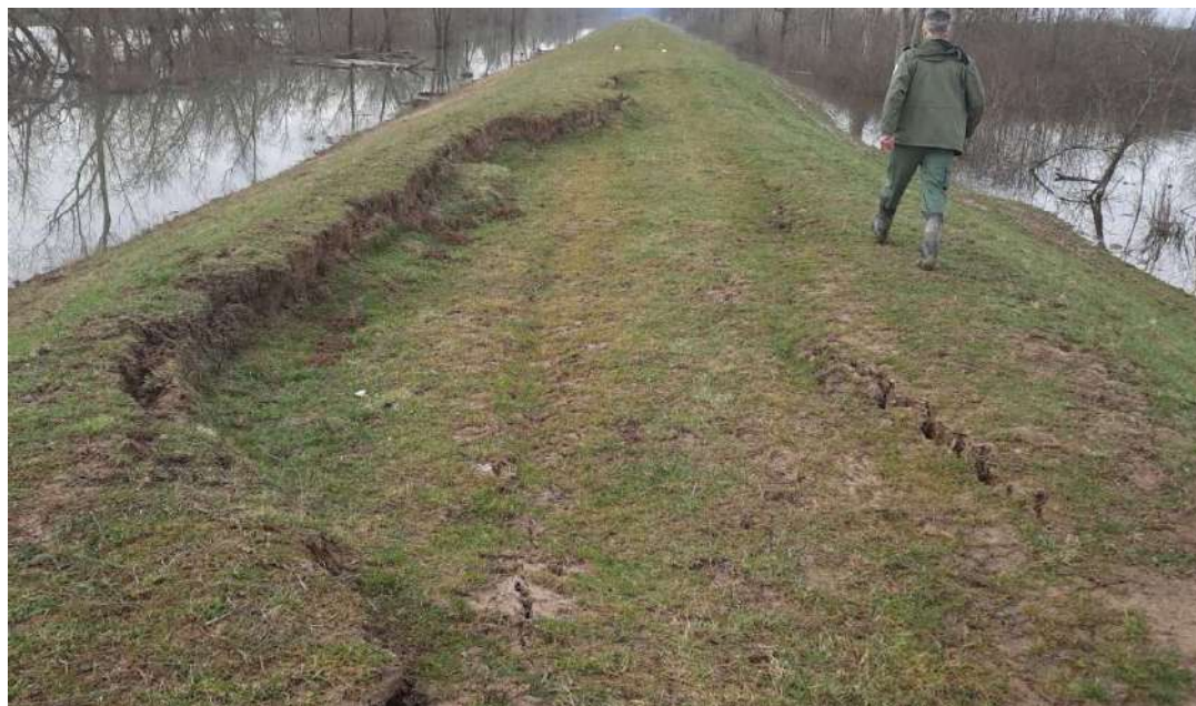
Grafički prikaz 3-7: Izgled nasipa u n.km 6+200 nakon potresa
