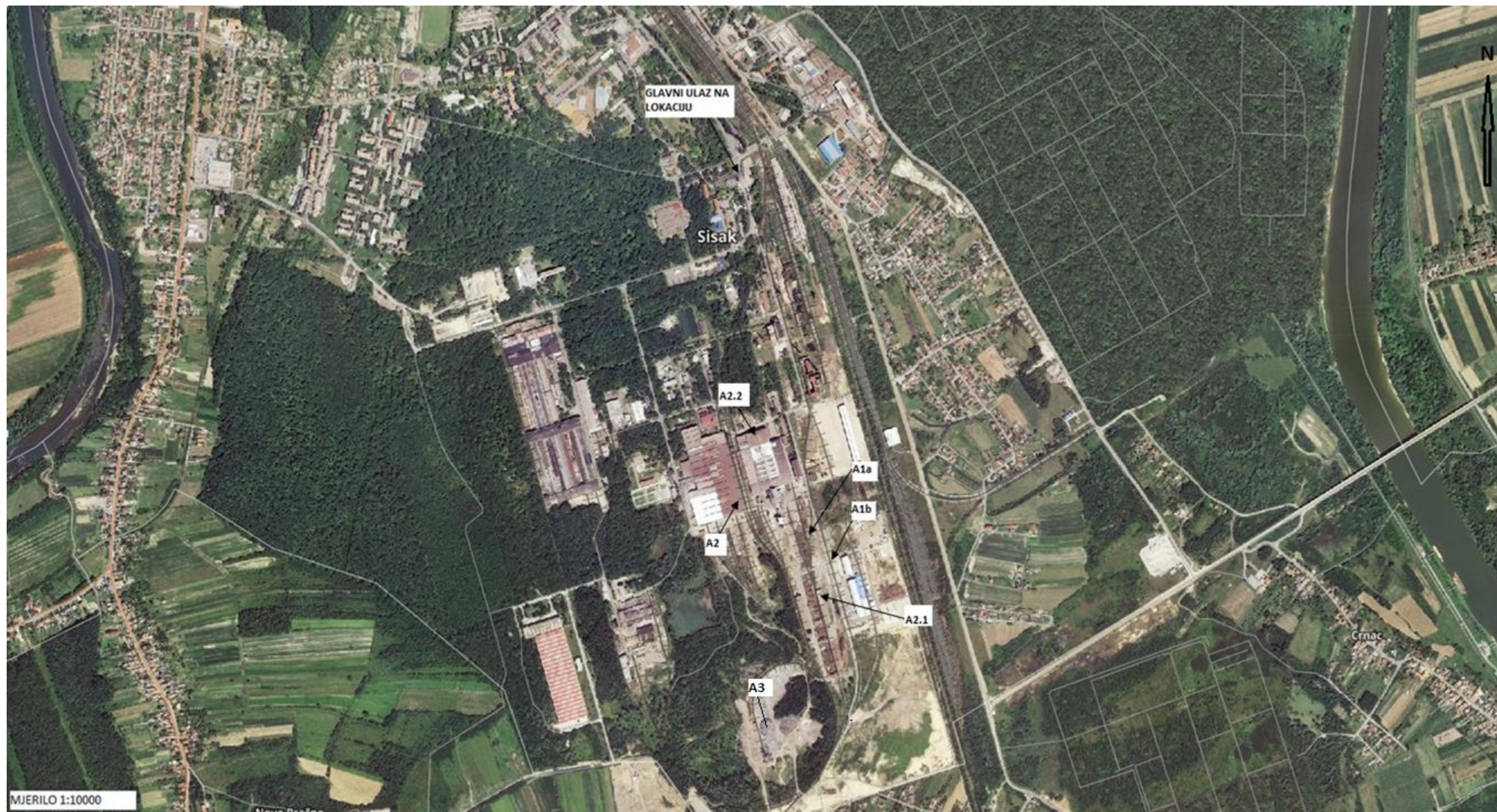
Slika 1. Prostorni razmještaj tehnoloških postupka gospodarenja otpadom na lokaciji tvrtke ABS Sisak d.o.o., Izvor: www.dgu.hr
