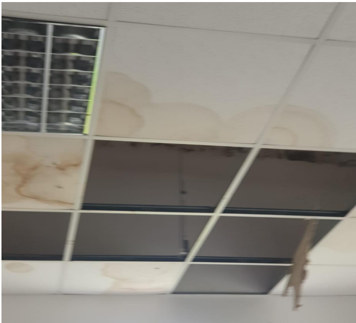
Slika 9. Oštećenja stropa
