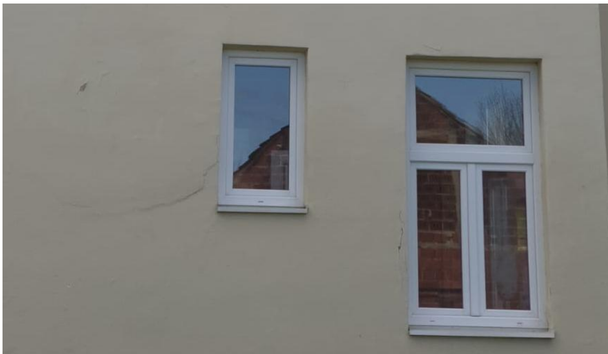
Slika 7. Oštećenja na sjevero-zapadnom pročelju
