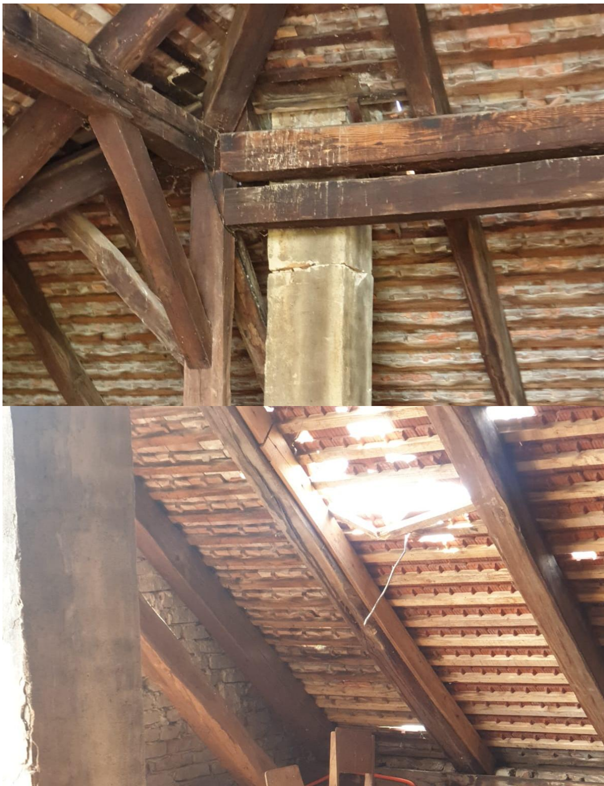
Slika 10. Oštećenja dimnjaka i krova
